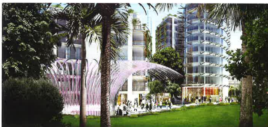
One Monte-Carlo, un quartier de tourisme et d'affaires imaginé pour le 3 ème millénaire par les architectes Richard Rogers et Alexandre Giraldi
